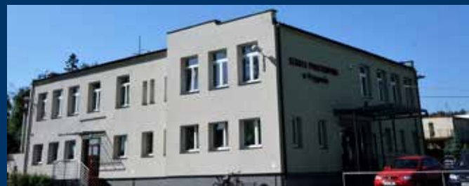
Przy SP w Pręgowie postanie hala sportowa
